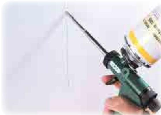
图8：用发泡胶填充板缝
